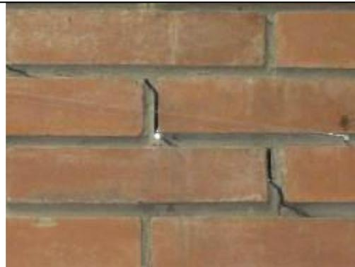
Fisuras en elementos estructurales una vez instalado el mezzanine metálico
